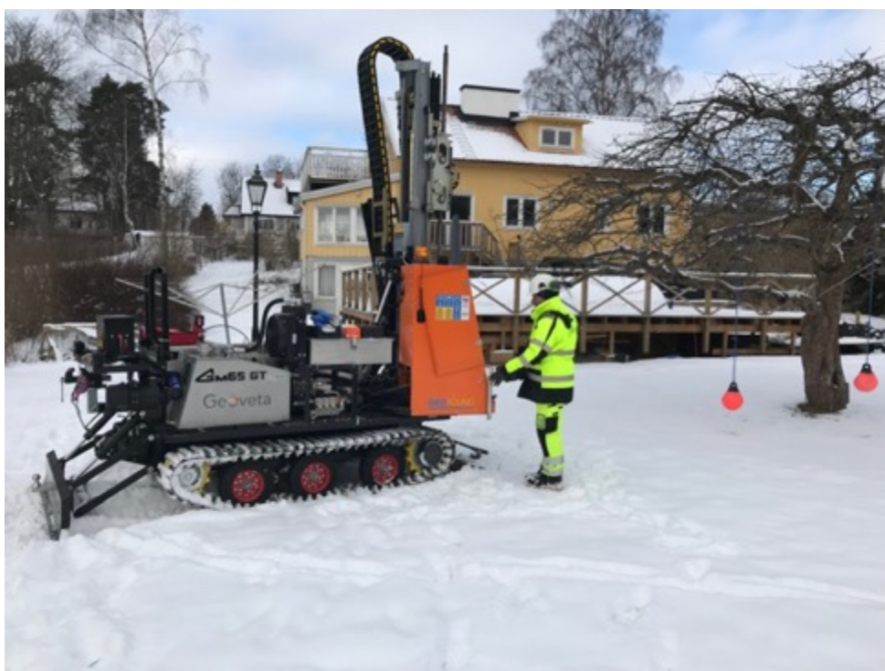
Bilden visar geoteknisk sondering på Strömningen. Bilden tagen av Geoveta 2018-02-26.
