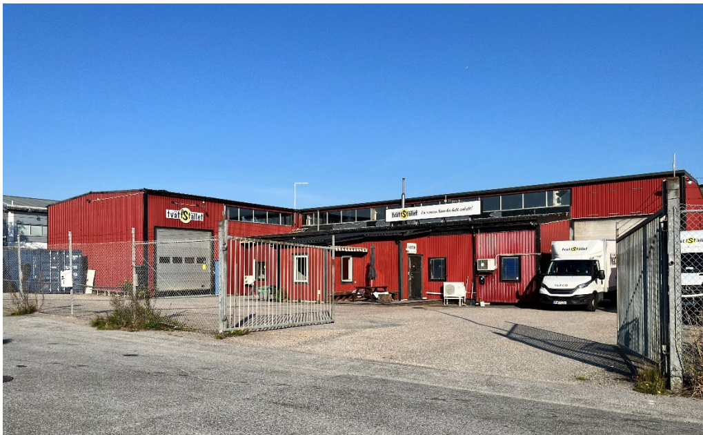
Figur 5. Vy längs Svetsarvägen mot fastighet Bensinen 4.
