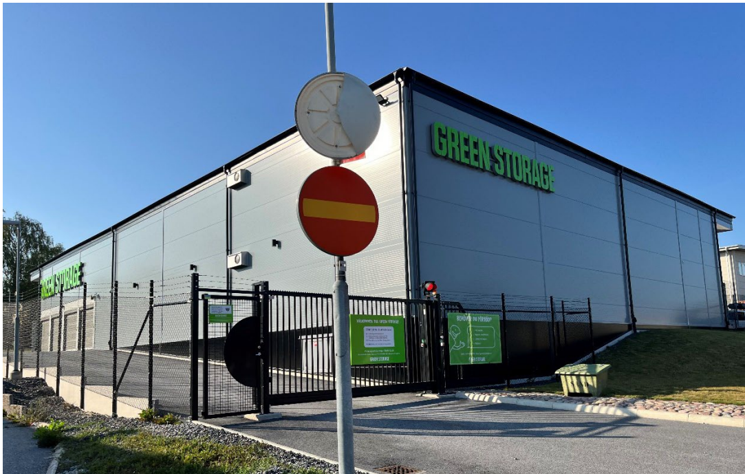
Figur 7. Vy längs Svetsarvägen mot fastighet Veden 103.
