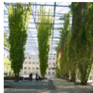
”Gröna pelare” i form av klätterväxter på stålställning
