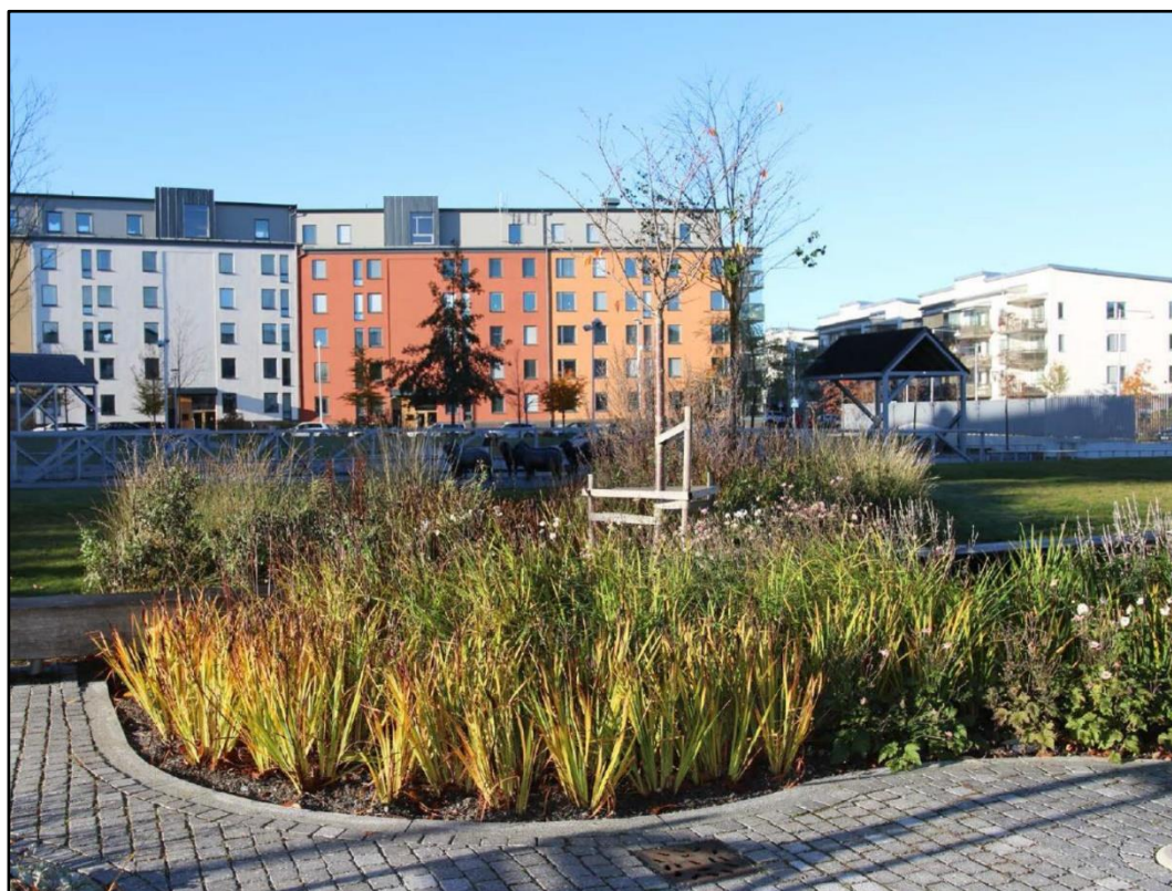
Figur 5-2. Exempel på nedsänkt växtbädd (Solna stad dagvattenstrategi, 2019).
