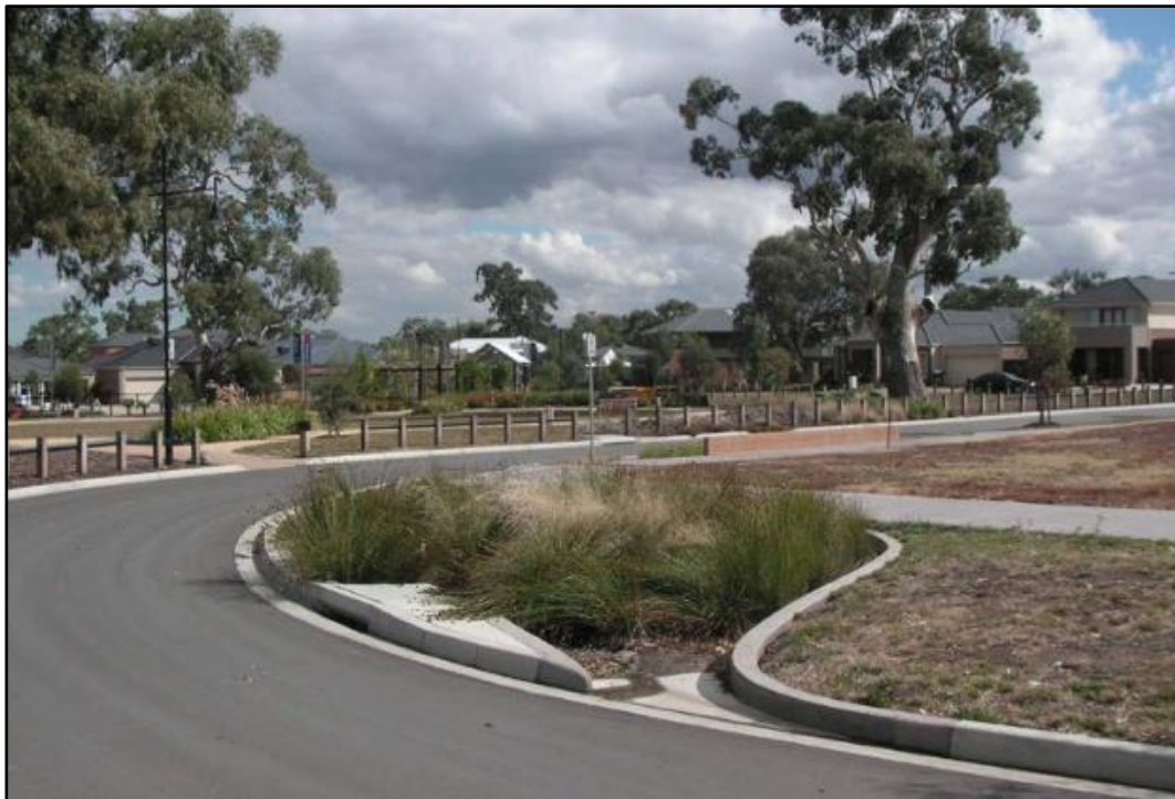
Figur 5-4. Öppning i kantsten, inlopp till växtbädd (Waterbydesign, 2014)
