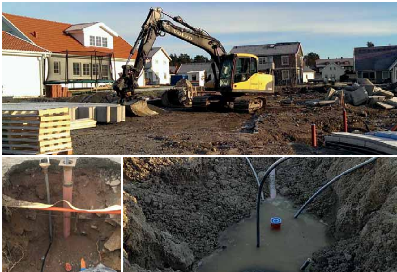
Utbyggnad av privata VA-ledningar till förbindelsepunkter strax utanför fasthetsgräns.
