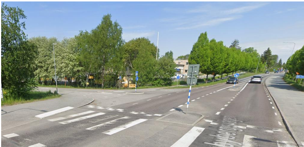
Figur 29. Vy norrut i korsningen Täbyvägen/Enebybergsvägen-Svampvägen.
