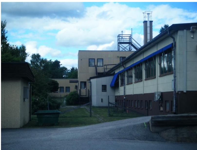
Figur 28. Industribyggnaden på Bromsen 11 innan ny exploatering.
