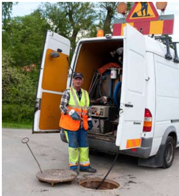
Håkan Lantz spolar spillvattenledningar för att undvika avloppsstopp.
