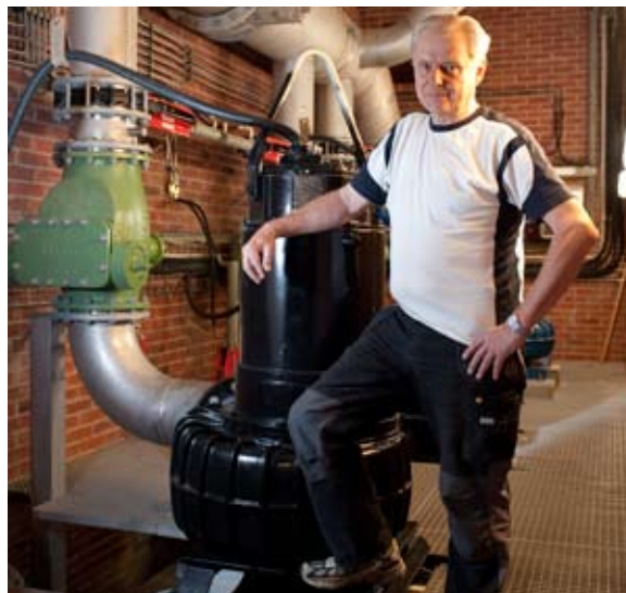
Lars Bergqvist vid en av pumparna i Sjöängens pumpstation.
