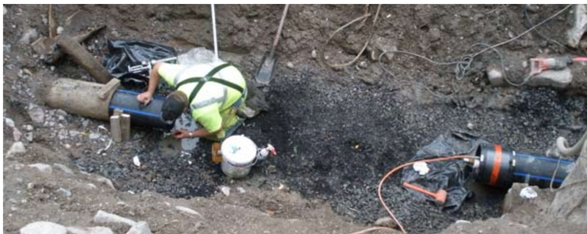
Renovering av vattenledning.
