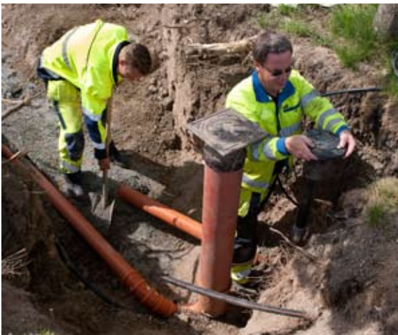
Anläggning av nya vatten- och avloppsledningar till fastighet, så kallad VA-servis.
