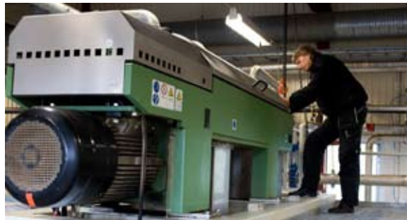
Kontroll av centrifug som avvattnar slammet.
