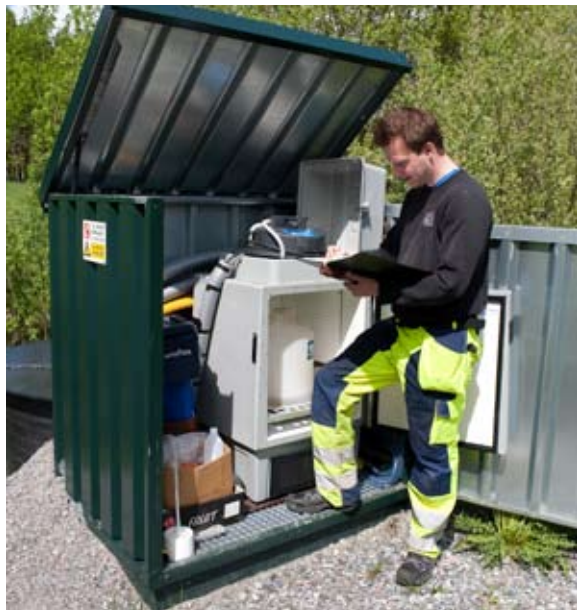
Flödesmätning och provtagning av dagvatten.
