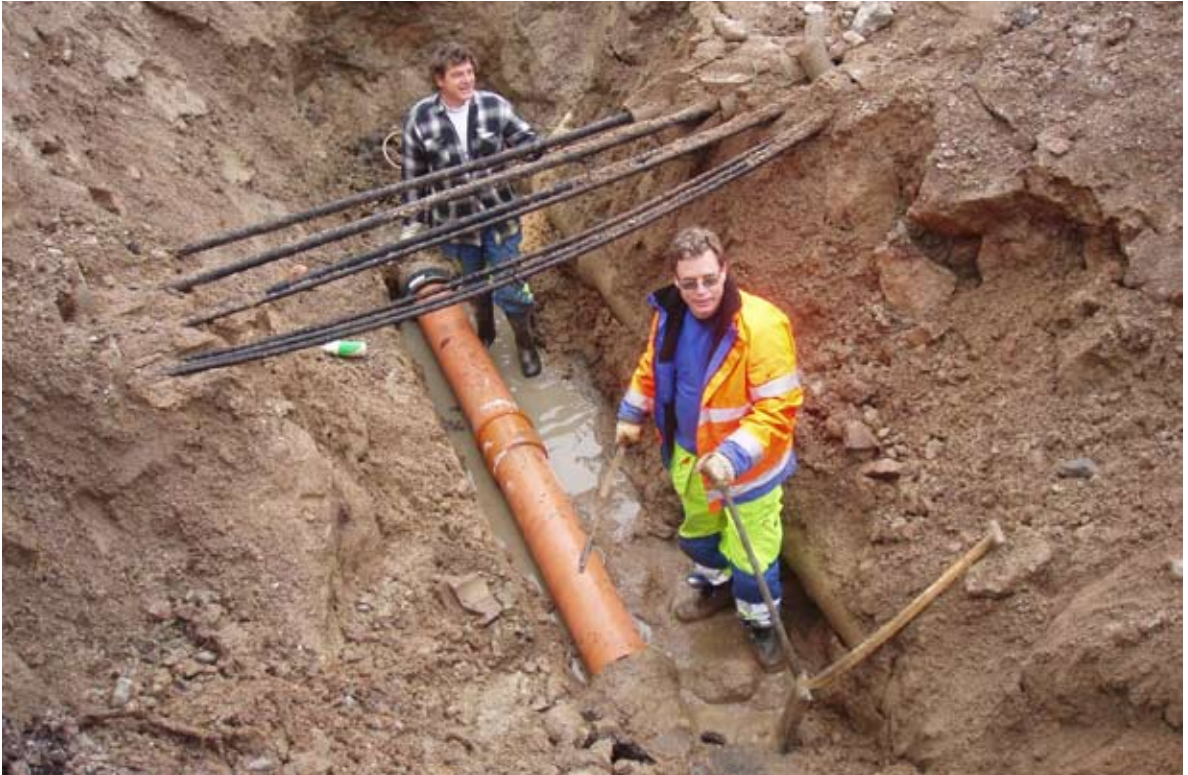
Ebbe Ländin och Dan Svensson lagar en avloppsledning.
